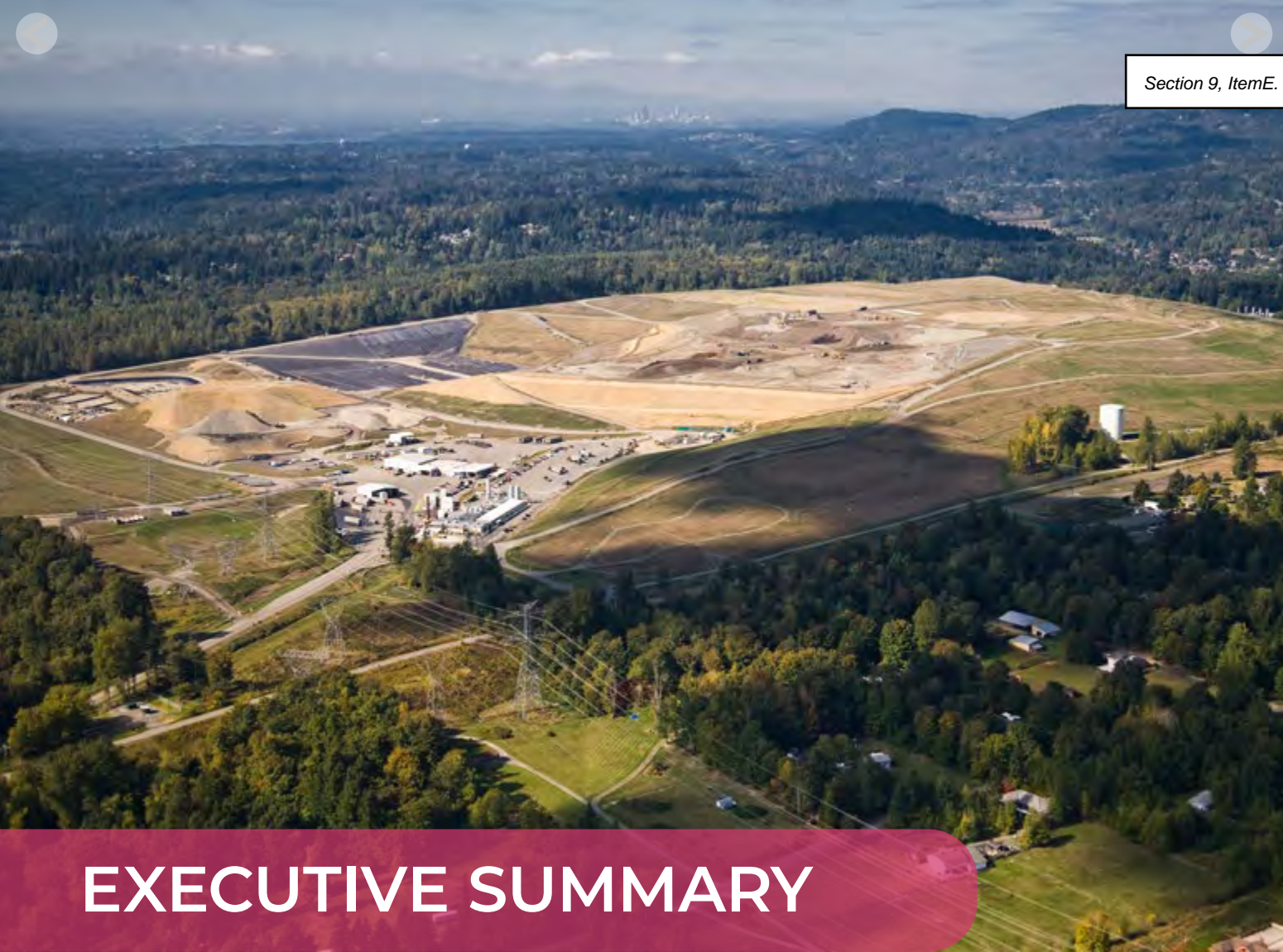
Cedar Hills Regional Landfill
